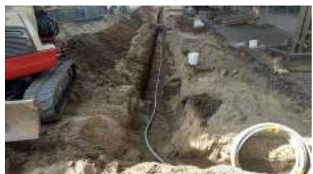
Sleuf bij invalideningang
