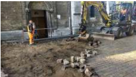
Verwijderen straatwerk
