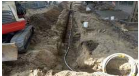
Sleuf bij invalideningang
