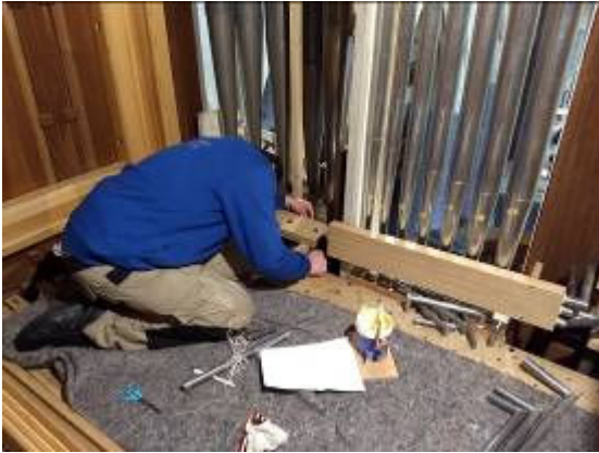
Het leggen van de conducten (verbindingspijpjes)
