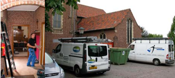
Renovatie kerk Herten
